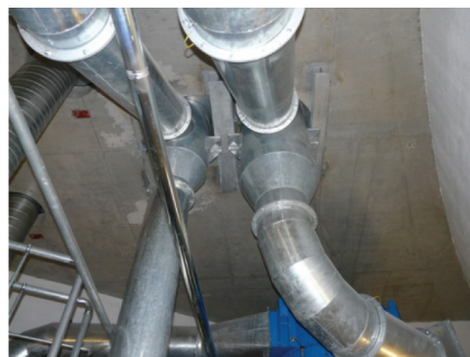
Abb. 1: Entkopplung des Staubfilters sowohl im Rohgaseintritt als auch im Staubaustrag
