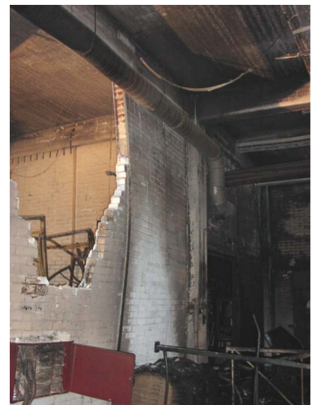
Abb. 3: Auswirkungen einer Staubexplosion
