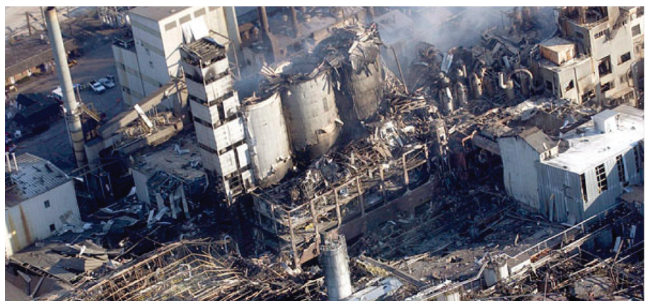
Abb. 4: Raffinerie der Imperial Sugar in Port Wentworth, Georgia/USA nach der Zuckerstaubexplosion im Februar 2008
