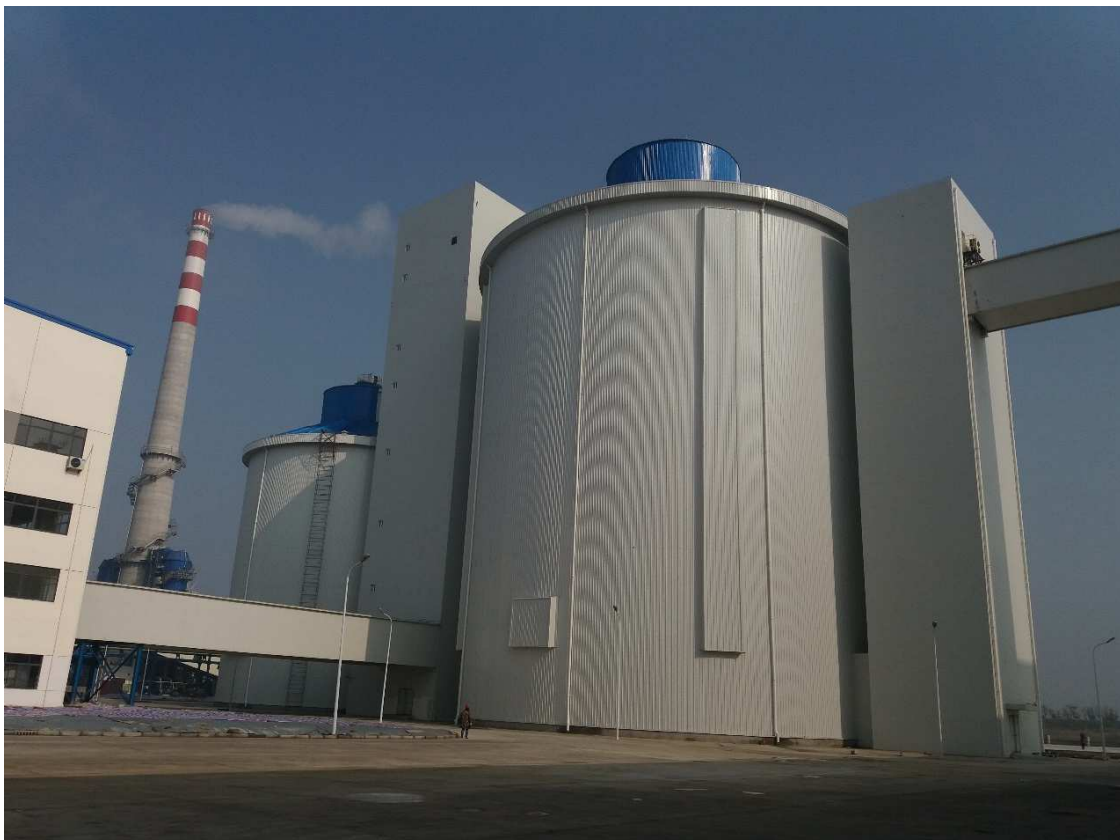
Bild 1: Gesamtansicht des Bauobjektes (Silogrößen: \varnothing 25,0 m x 39,1 m hoch und \varnothing 35,0 m x 54,2 m hoch)
